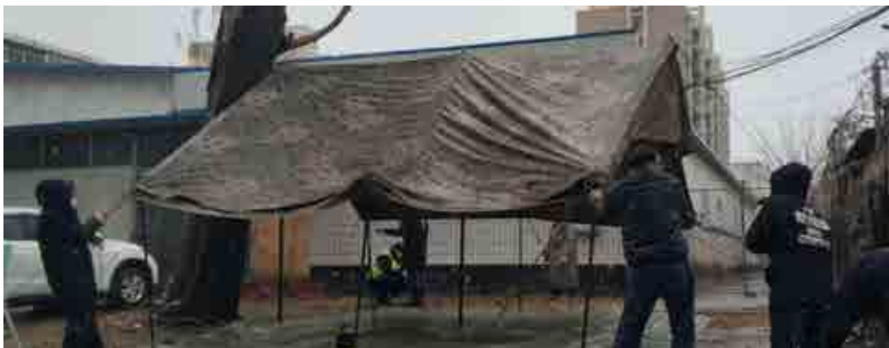
⑪ 工程部搭建防雨棚
