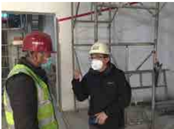
⑩ 进行机房情况勘查
